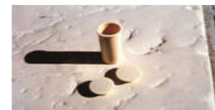
Perçage au sol Ø30
